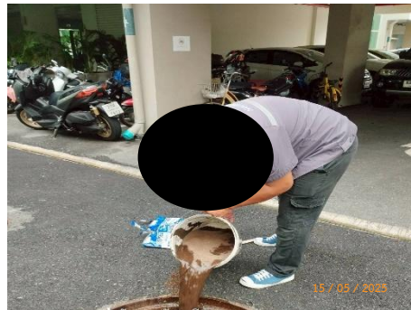
รูปที่ 2-38 การเติมจุลินทรีย์ในบ่อเกรอะเพื่อลดการเกิดตะกอน
