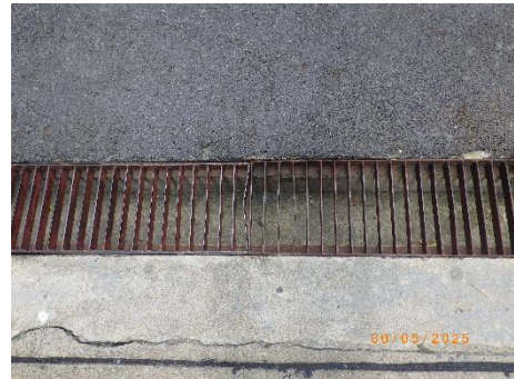
รูปที่ 2-48 ตะแกรงดักขยะมูลฝอยในบ่อตรวจสอบการระบายน้ำ
